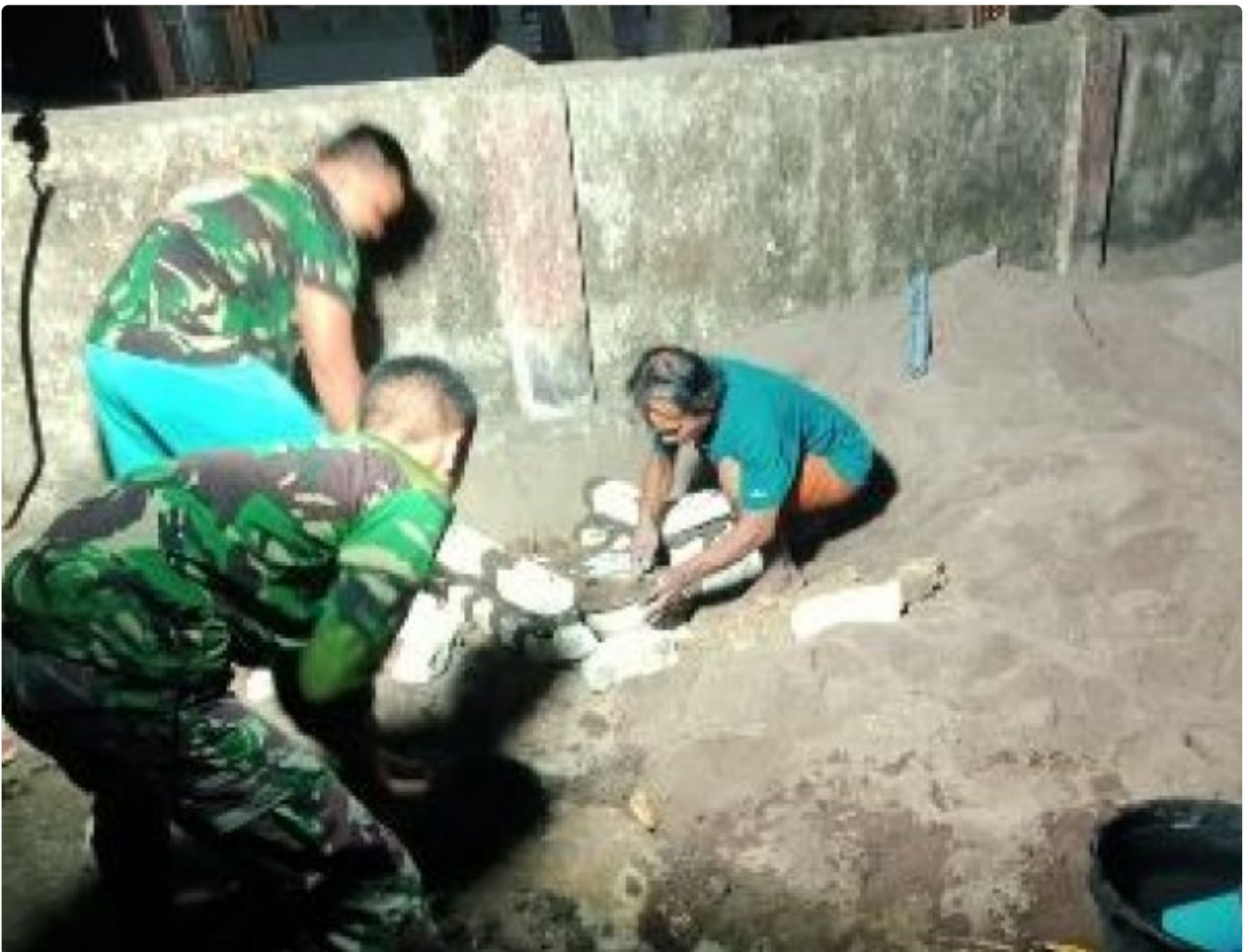
Satgas TMMMD Ke-118 Kodim 0829/Bangkalan sedang mengerjakan pembangunan batu monumen (Prasasti) TMMMD Ke-118 Tahun 2023
